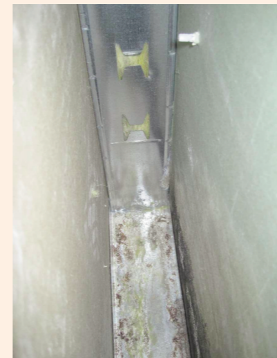
5 Schimmel auch auf der Rückseite der Trennwand und Rost an den Profilen.
